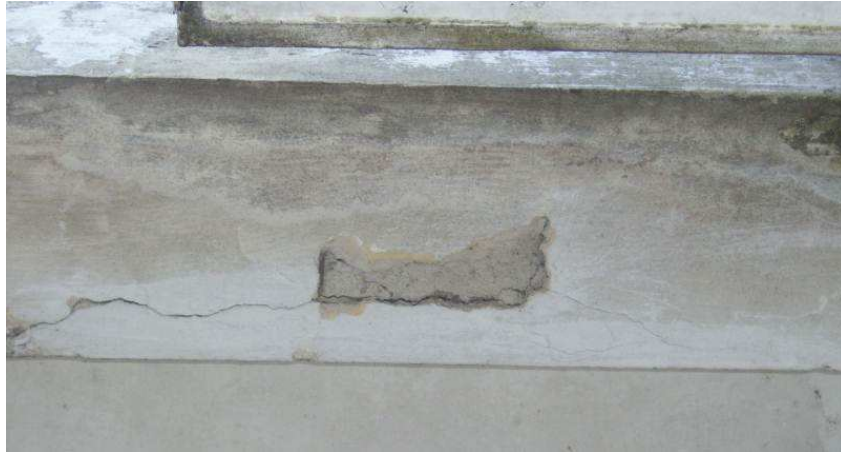
Imágenes de desprendimientos de revoque en viga V21
