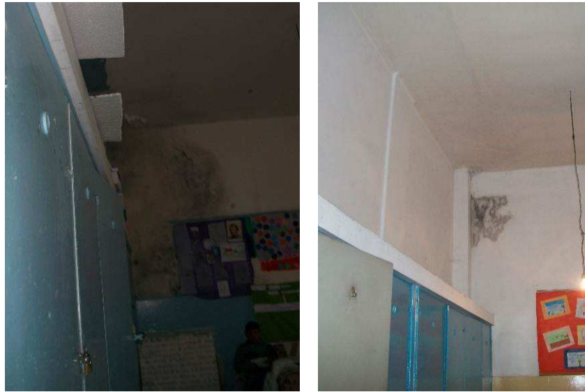
Imágenes de humedad en salón de planta alta (izquierda) y planta baja (derecha)
