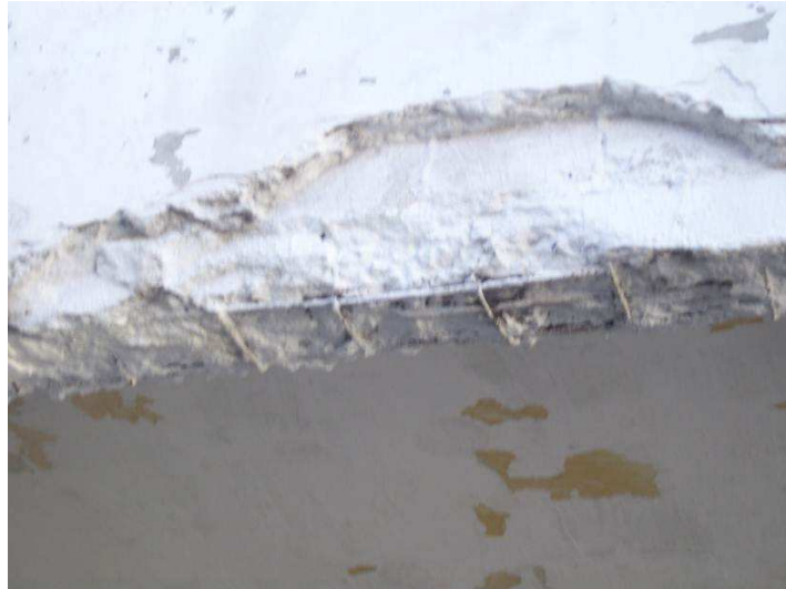
Imágenes de las armaduras expuestas en viga V21, se puede observar también el gran espesor del revoque.
