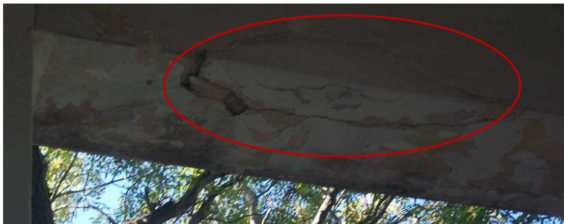
Imagen de fisuras que indican alta probabilidad de desprendimiento de trozos grandes de revoque en V59.
